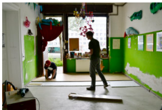
灰色のコンクリートの床も悪くはなかったが、やはり木製の床には敵わない! 地階からの冷気を防ぐため、発泡スチロールの板を間に敷いた。
